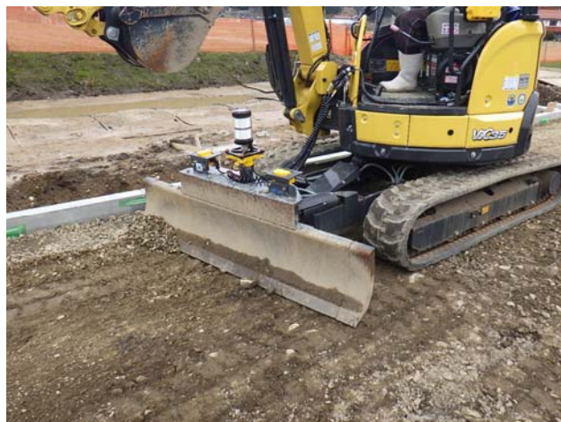
排土板制御システム流用(幅1.55m)
