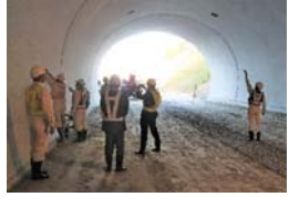
写真3. トンネル断面完成状況
