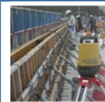
自動追尾TS壁高欄型枠設置高・床版高さ計測
