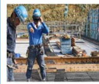
配筋作業者のMRデバイス装着
