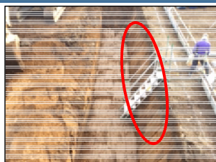
オープンカット法面整形(60°3D) つぼ堀 床付け(3D:2D+深さ)
