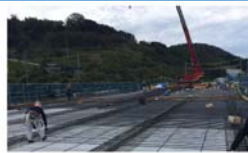
配筋作業状況
