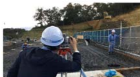
床版型枠高さ計測状況
