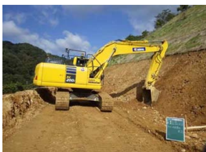
ICT建機による施工(イメージ)
