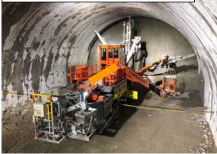
世界初のトンネル施工機械 (自動ロックボルト打設機能付き)
