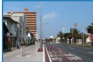
電線類の地中化
