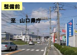
(H19年3月撮影) 電線類が張り巡らされた街並み
