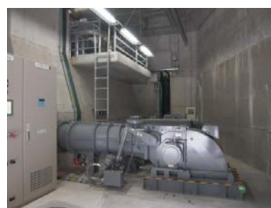
管理用発電施設内 水車・発電機
