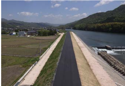
河川改修（奈美地区）
