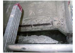
鉄筋露出の状況
