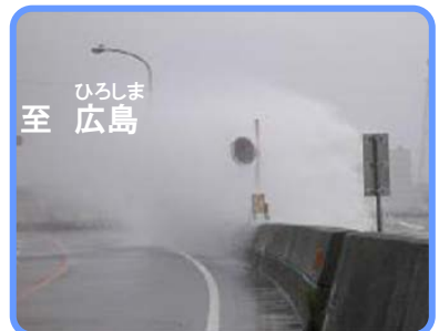
越波による全面通行規制が発生 (H17年9月)
