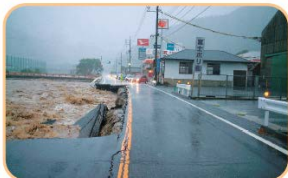
平成16年8月台風16号による 国道2号の被害(岩国市保木)
