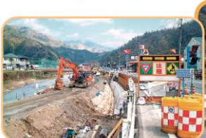
復旧工事の様子
