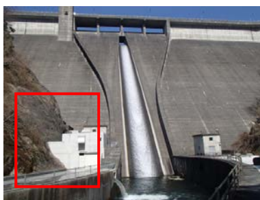
管理用発電施設(H24年度設置)
