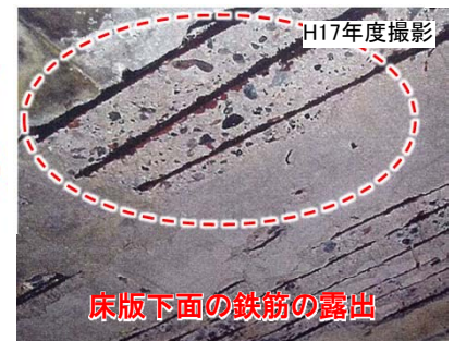
< 架け替え前の旧橋の老朽化の状況 >
