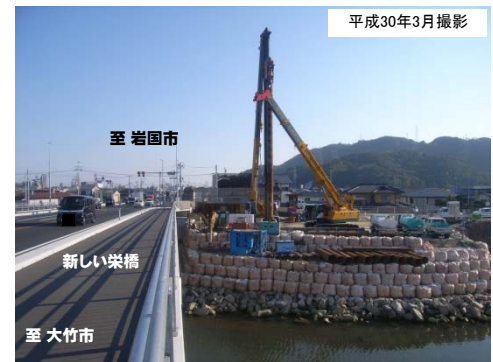
写真② 現在の工事状況
