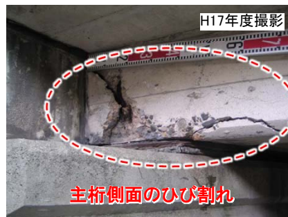
< 架け替え前の旧橋の老朽化の状況 >
