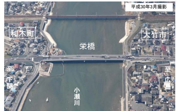
写真① 栄橋の供用状況
