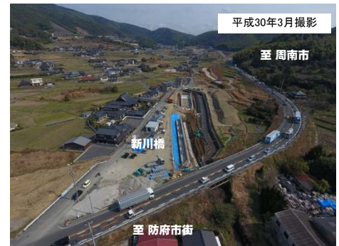
写真② 現在の橋梁工事進捗状況 (防府市街方面から周南市方面を望む)
