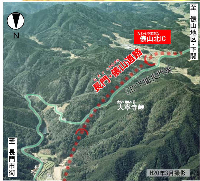
下関長門線 大寧寺峠周辺の道路状況 (写真①)
