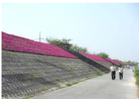
法面植栽(芝桜)を行った佐波川堤防
