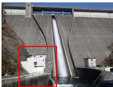
管理用発電施設(H24年度設置)
