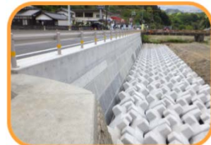
復旧後の状況(H31年4月26日)
