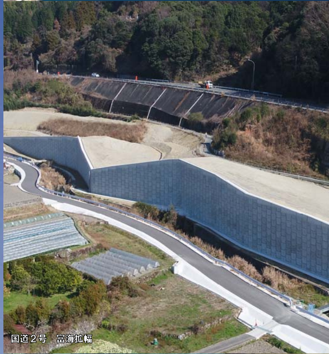
国道188号 藤生長野バイパス
