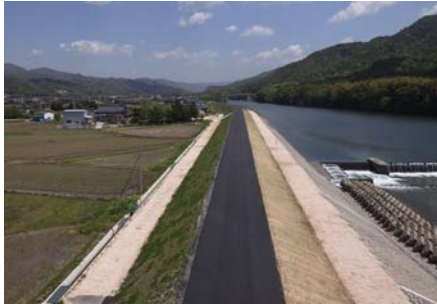
河川改修（奈美地区）
