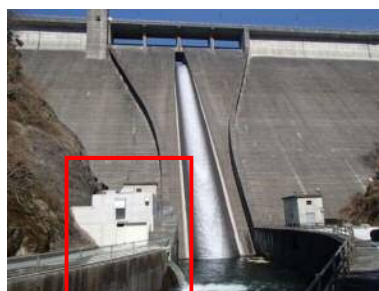
管理用発電施設(H24年度設置)
