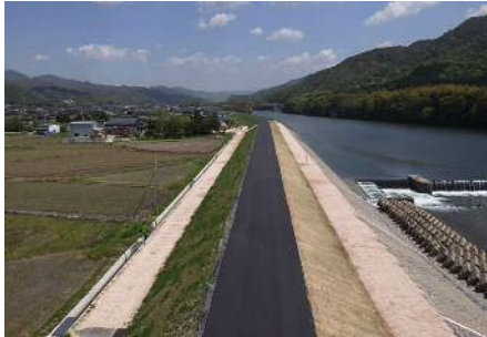
河川改修（奈美地区）
