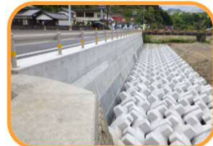
復旧後の状況(H31年4月26日)
