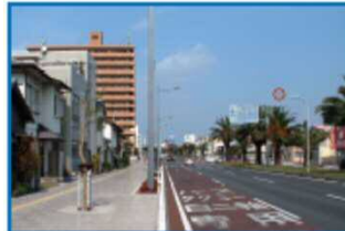
電線類の地中化
