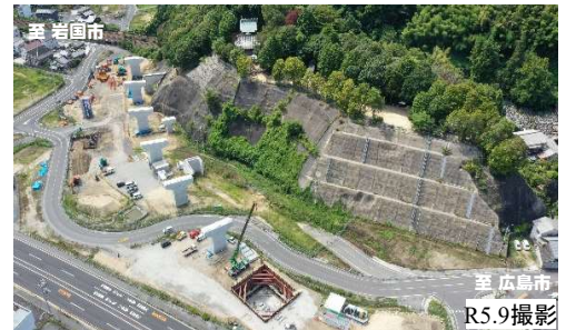
【写真①】大竹市小方地区の施工状況
