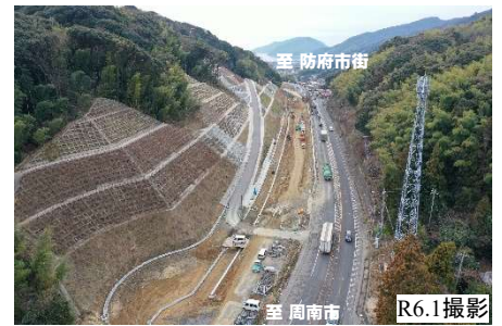
【写真①】樺峠地区の法面施工状況
