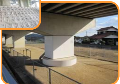
鋼板巻き立て補強
