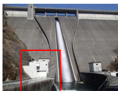
管理用発電施設（H24年度設置）
