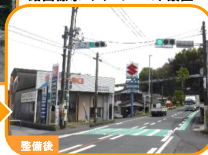
路面標示・グリーンベルト設置
