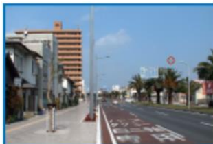
電線類の地中化
