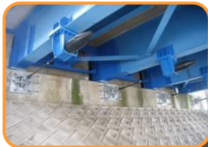
落橋防止構造
