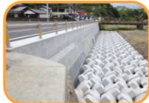
復旧後の状況(H31年4月26日)
