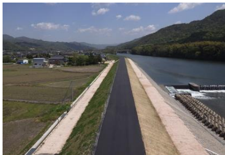
河川改修（奈美地区）
