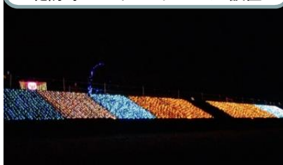
堤防等へのイルミネーション設置
