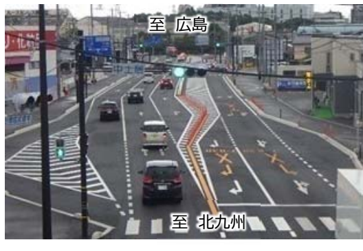
<対策後の現地状況>
