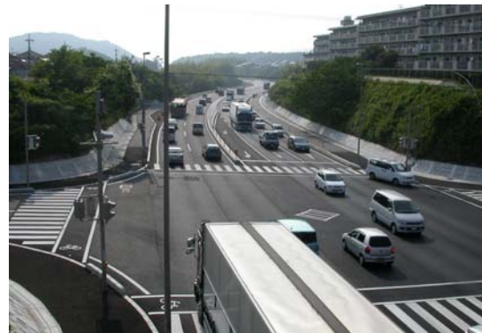
バイパス部の状況
