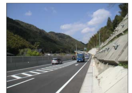
県道岩国大竹線 関々バイパス
