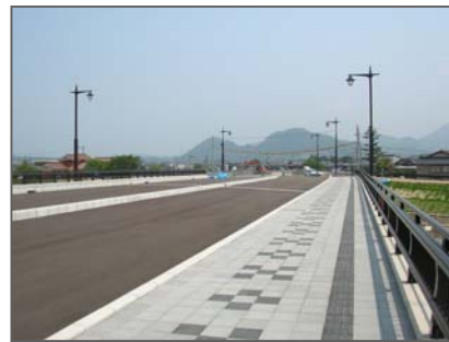
施工中の状況(萩バイパス)
