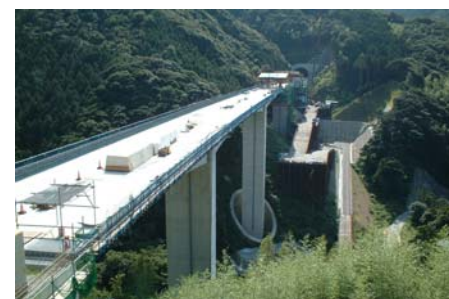
写真2 飯井第2トンネルから飯井第1トンネル方面
