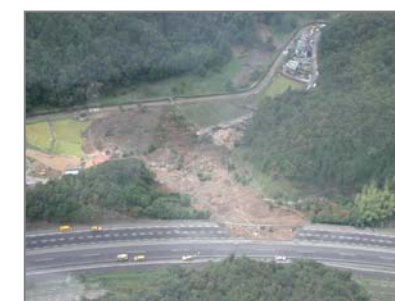
盛土崩壊の状況 山陽自動車道(岩国IC～玖珂IC)
