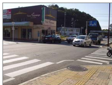
③県道光玖珂線 光市島田交差点のカラー舗装
