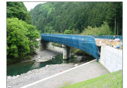
施工中の状況
