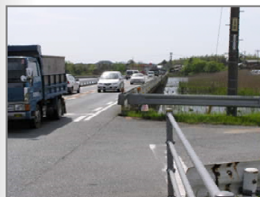
①国道2号 山口市長沢交差点改良
