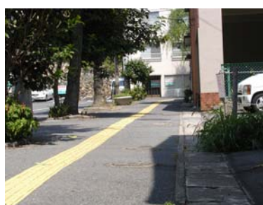
④市道中之町5号線 下関唐戸歩道段差解消、点字ブロックの設置
