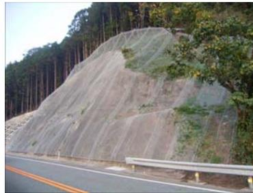
大規模斜面の落石防護工
