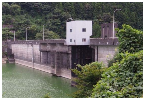
事前放流で水位を下げる前の状況 (※これから約0.9m下降させました)
