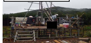
ボーリング作業
