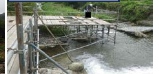
足場設置作業
