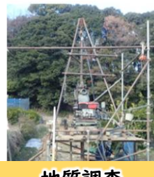
地質調査 (機械ボーリング)
