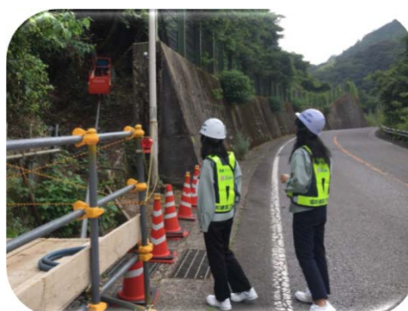
女性技術者による現場点検の実施。
