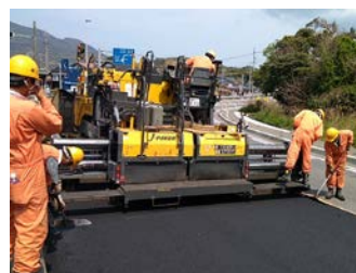
本線舗装敷設
