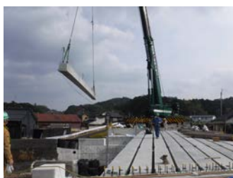
中津橋橋桁架設
