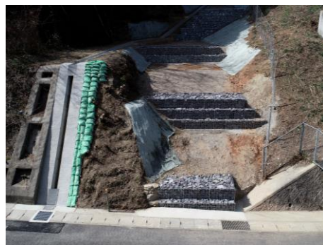
④工事完成（現在）
