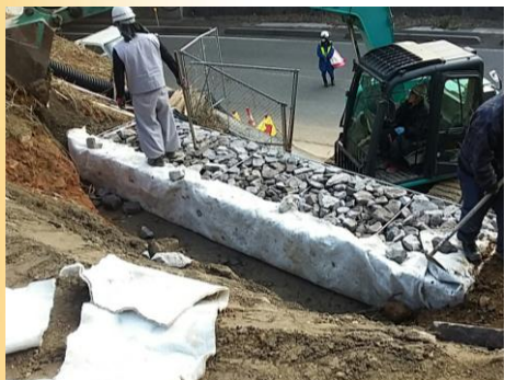
③工事施工中
