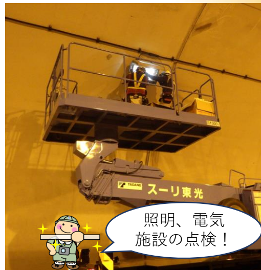
トンネル等 構造物の点検
