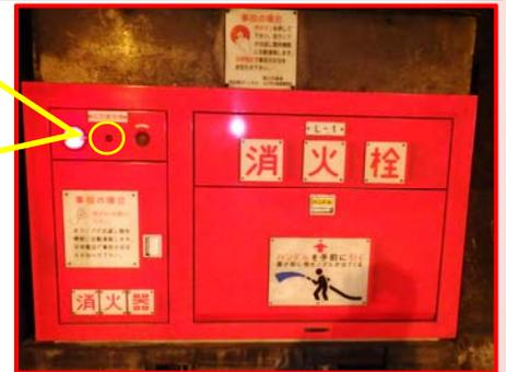
◎トンネル警報設備は、トンネル内での事故・火災等の発生時に、視野が限られるトンネル内外の車両・歩行者に対して避難経路等を知らせ、二次的災害を回避するためのものです。また、迅速な事故対応のため道路管理者・警察・消防へ自動通報もされます。
