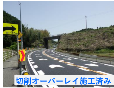
舗装改修箇所（切削オーバーレイ・カラー舗装・区画線）
