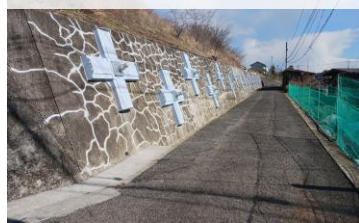
擁壁 亀裂をシーリング 受圧板+グラウンドアンカー
