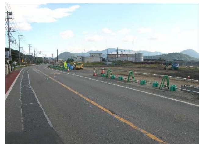
■写真③<11月の施工状況>
