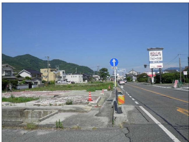
■写真②<施工前>
