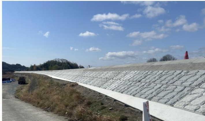
【After】令和8年3月 工事完成予定
