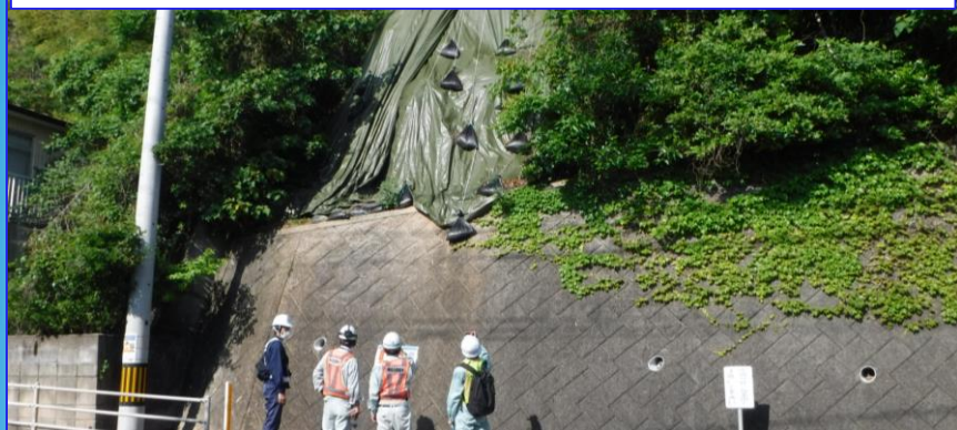
法面から土砂が崩落した箇所に異常が無いことを確認
