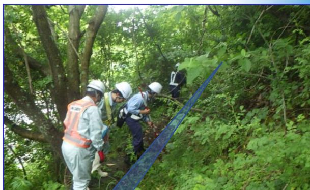
法面の水路の状況を確認 水路の詰まりを早期に清掃を実施
