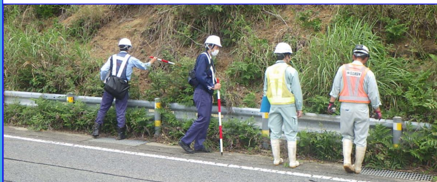
法面から土砂のはらみだし状況に変動が無いことを確認
