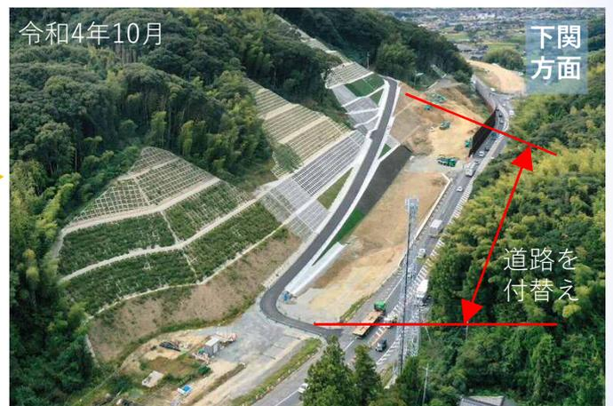
**戸田山地区** 椿峠地区で掘削した土砂で盛土を施工しています
