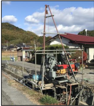
▲機械ボーリング
