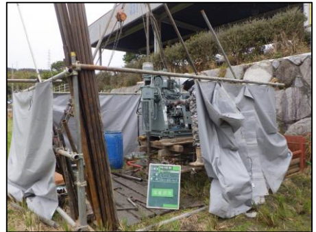
▲機械ボーリング
