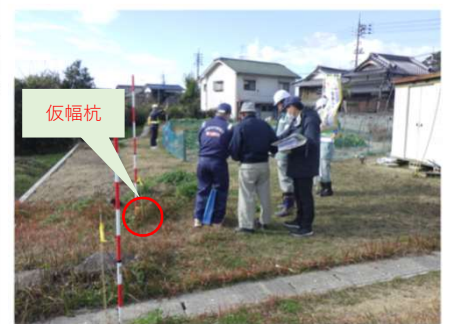
仮幅杭立会の説明状況
