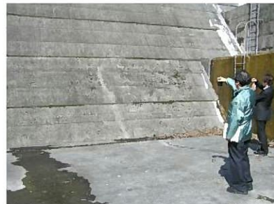
堤体検査状況
