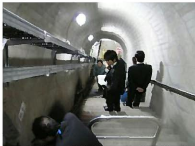
監査路内検査状況
