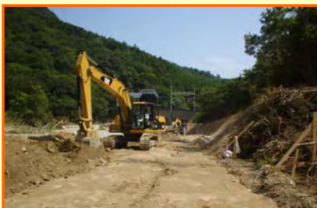
工事用道路建設状況 (素川)
