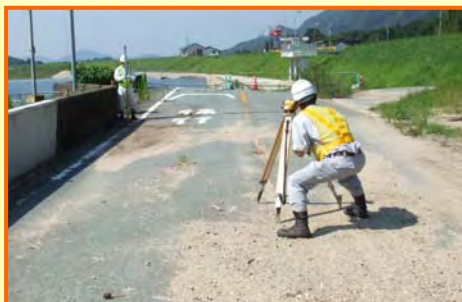
佐波川 縦横断測量状況
