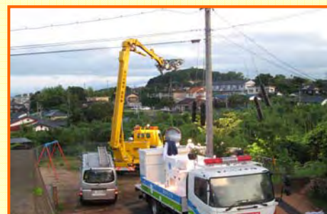
排水ポンプ車・照明車設置状況 (宇部市)
