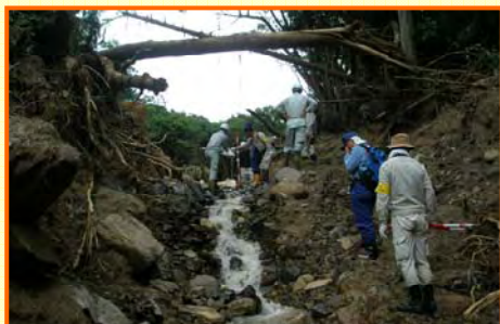
緊急点検状況 (山口県防府市牟礼)
