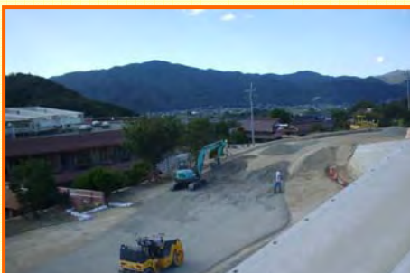
工事用道路建設状況 (上田南川)
