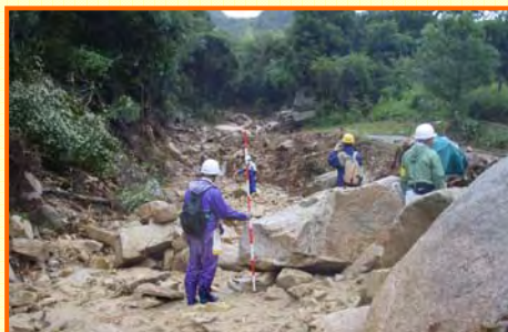
緊急点検状況 (山口県防府市下右田)
