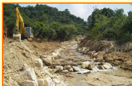
水路付替完了 (剣川)
