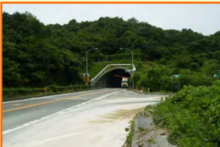
防府第2トンネル
