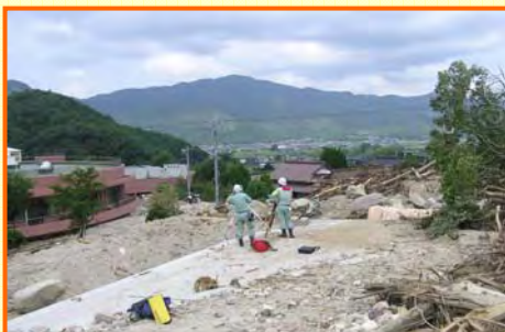
測量状況 (上田南川)
