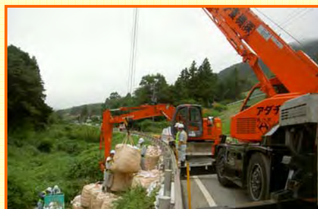
国道191号 応急対策状況
