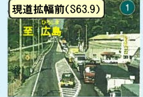
【花岡交差点付近の状況(広島方面を望む)】
