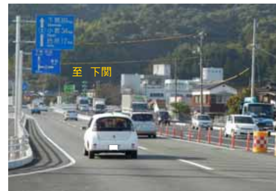
写真 : 開通後の状況 (広島方面から戸田交差点をのぞむ)
