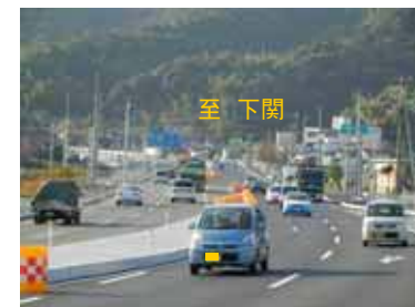
写真 : 拡幅後の状況 (起点付近から下関方面をのぞむ)
