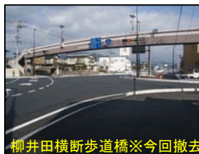
柳井田横断歩道橋※今回撤去
