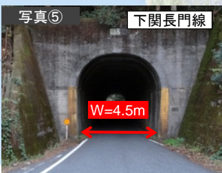
▲すれ違い困難トンネル (豊田湖沿いの葛尾隧道)
