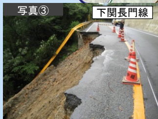
▲長門市俵山 (H21.7 被災状況)
