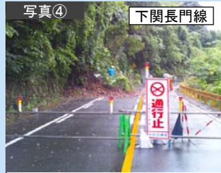
▲長門市俵山 (H25.9 被災状況)
