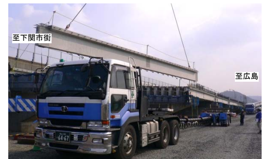
【写真②】木屋川大橋施工状況 (橋を架けています)
