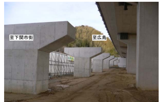
【写真①】松屋ランプ施工状況 (橋を造っています)
