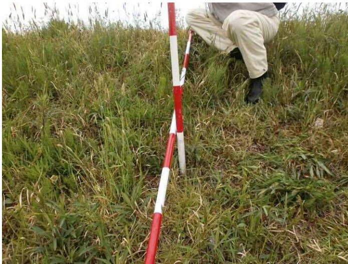
法面の沈下
