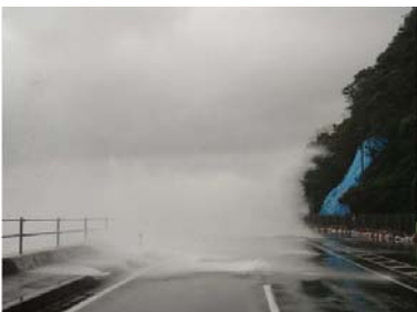
▲ 越波の発生状況
