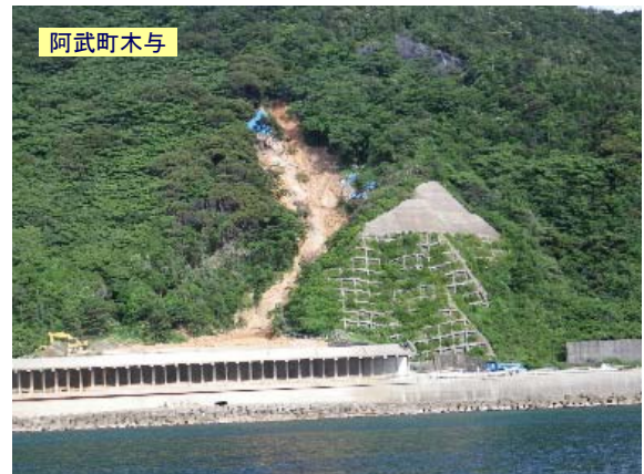
▲災害の発生状況
