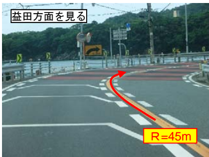
▲ 平面線形不良箇所
