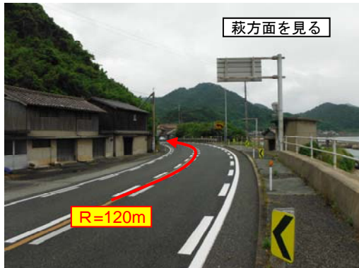
▲平面線形不良箇所
