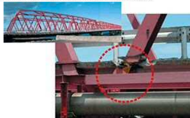
橋桁の破断
