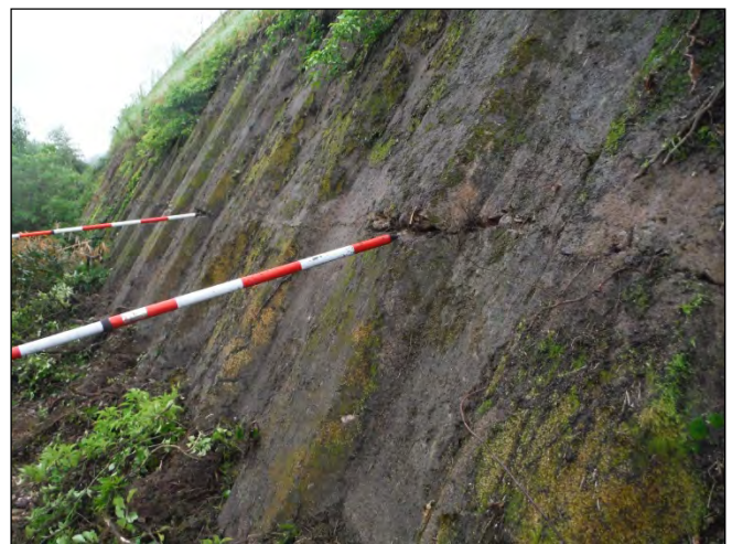
老朽化した護岸
