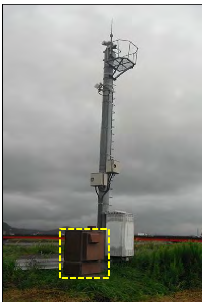
河川管理用カメラへの 無停電電源装置の設置例
