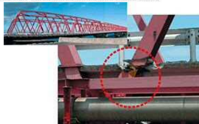
橋桁の破断
