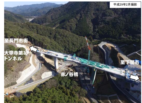
写真① 事業進捗状況 (長門市深川湯本(赤ノ谷)から長門市街方面を望む)
