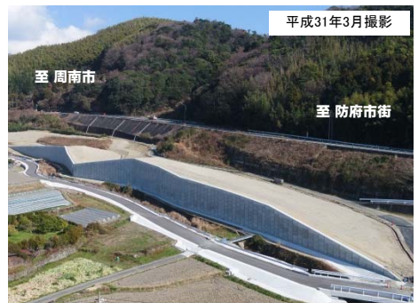
写真① 現在の改良工事進捗状況 (防府市街方面から周南市方面を望む)
