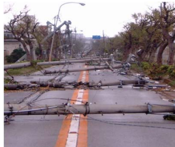
＜電柱の倒壊による道路閉塞の事例＞
