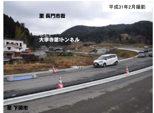
写真① 俵山小原地区 事業進捗状況
