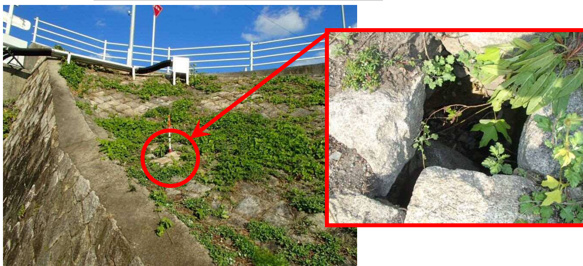
構造物のチェック(空洞化)
