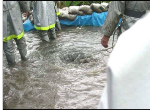
洪水時の堤防等の漏水
