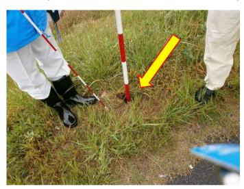
根固め石材・ブロックの崩れ
